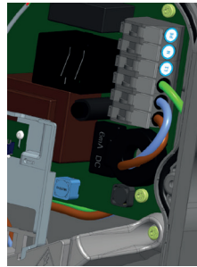
Abbildung 7: Anbringen einzelner Ladekabeladern.
